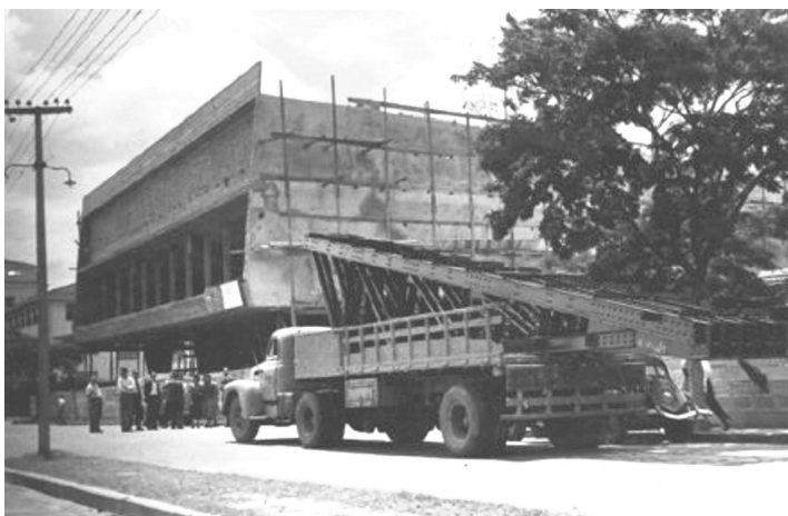
Figura 23 – Fase de acabamento, 1959.
