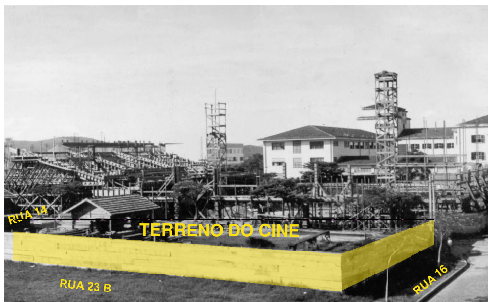
Figura 35 - Início das obras de construção do Cine.
