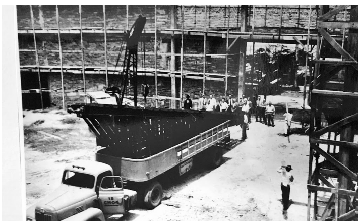
Figura 22 – Conclusão da Alvenaria.
