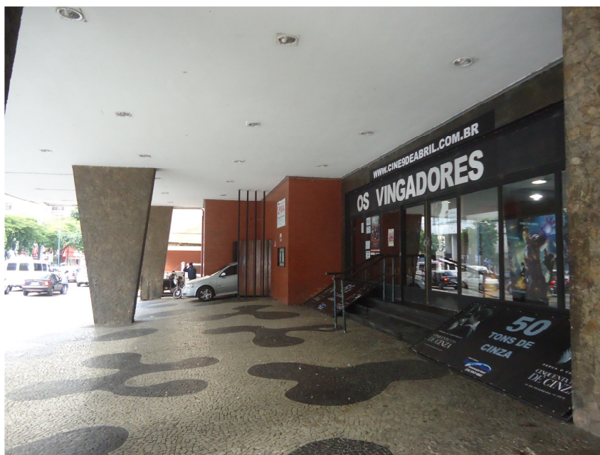
Figura 11 – Calçada da Fachada Principal.
